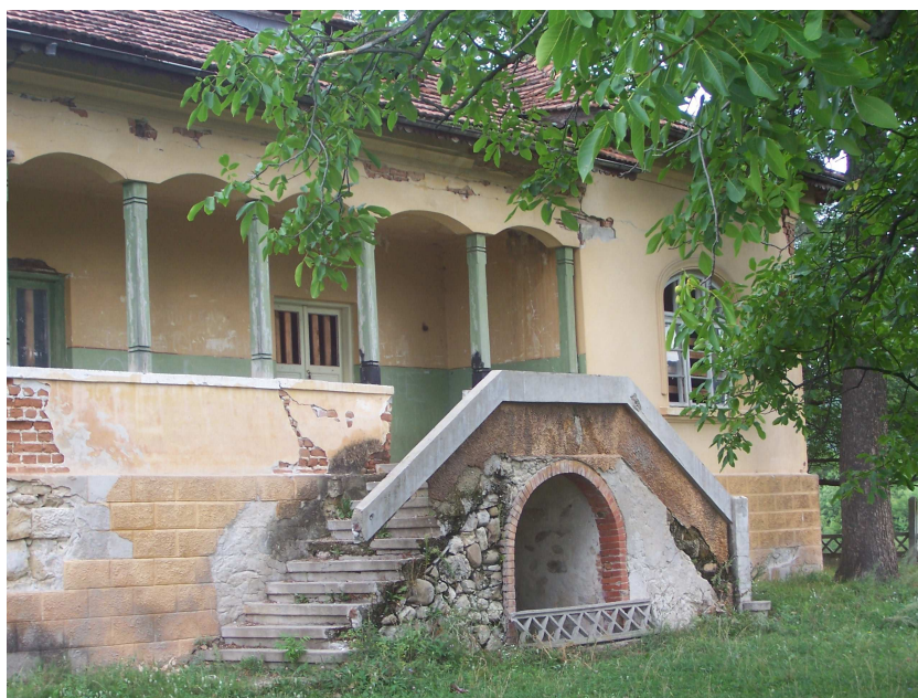
Foto 3. Clădirea în care a funcționat Dispensarul Medical Cojanu. Poza este făcută în septembrie 2007. Familia fostului boier Constantin Dumitrescu a vândut clădirea unui baron local de prin Buzău, care a început să o reabiliteze.
